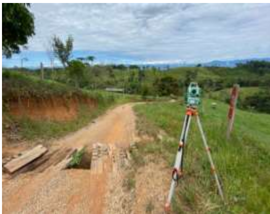
Gráfica 13. Vista general de la vía en tramo 02
