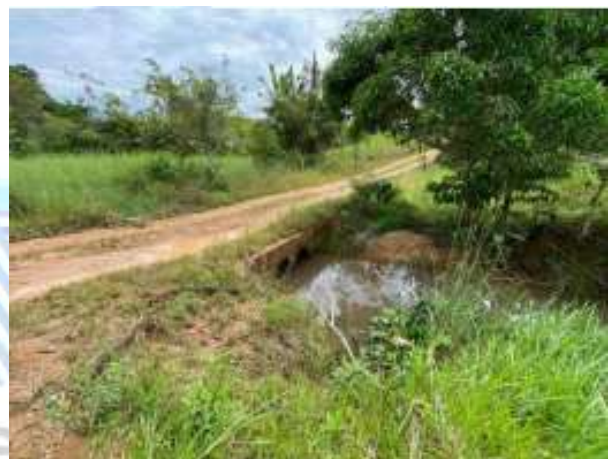
Gráfica 6. Vista general del punto para la construcción de Box Culvert 02.
