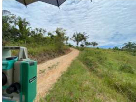
Gráfica 11. Vista general de la vía en tramo 01
