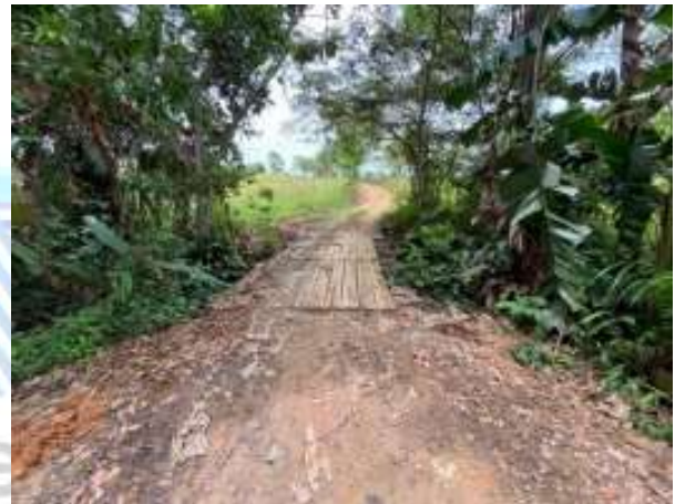
Gráfica 3. Vista general del punto para la construcción de Box Culvert 01.
