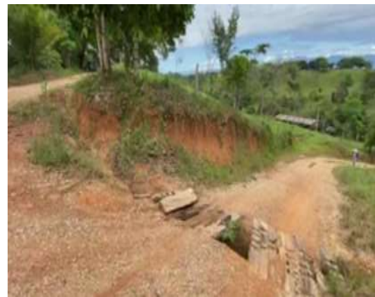
Gráfica 14. Vista general de la vía en tramo 02
