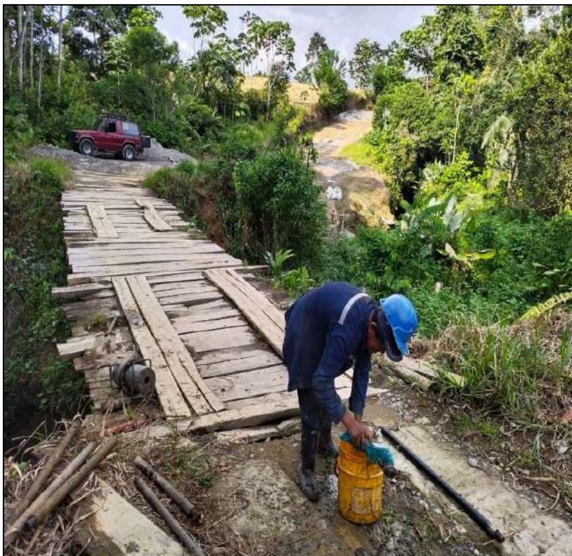
Figura 1: Zona de estudio (puente existente en madera)
