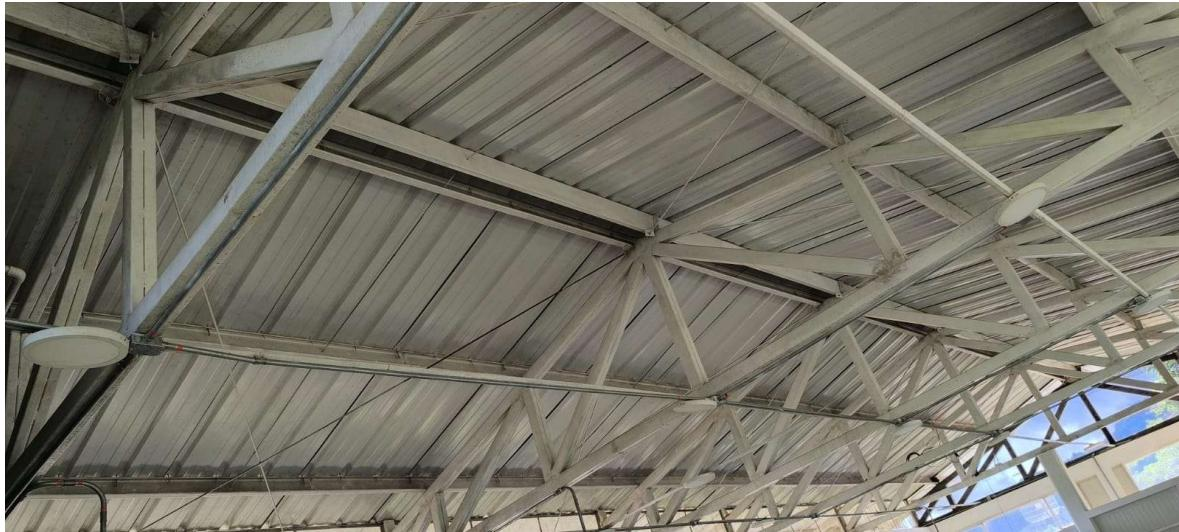
3. Vista exterior de la planta de COOMBUVIPAC donde se instalará la malla tipo zaranda 6x6 de 90 cms de alta en acero inoxidable situada entre el techo y la viga de la planta. De igual manera, se instalarán los canales en PVC sobre los dos lados de la caída del agua.
