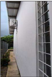
Estructura de cubierta
